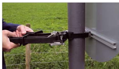
Fixation des panneaux de signalisation routière
