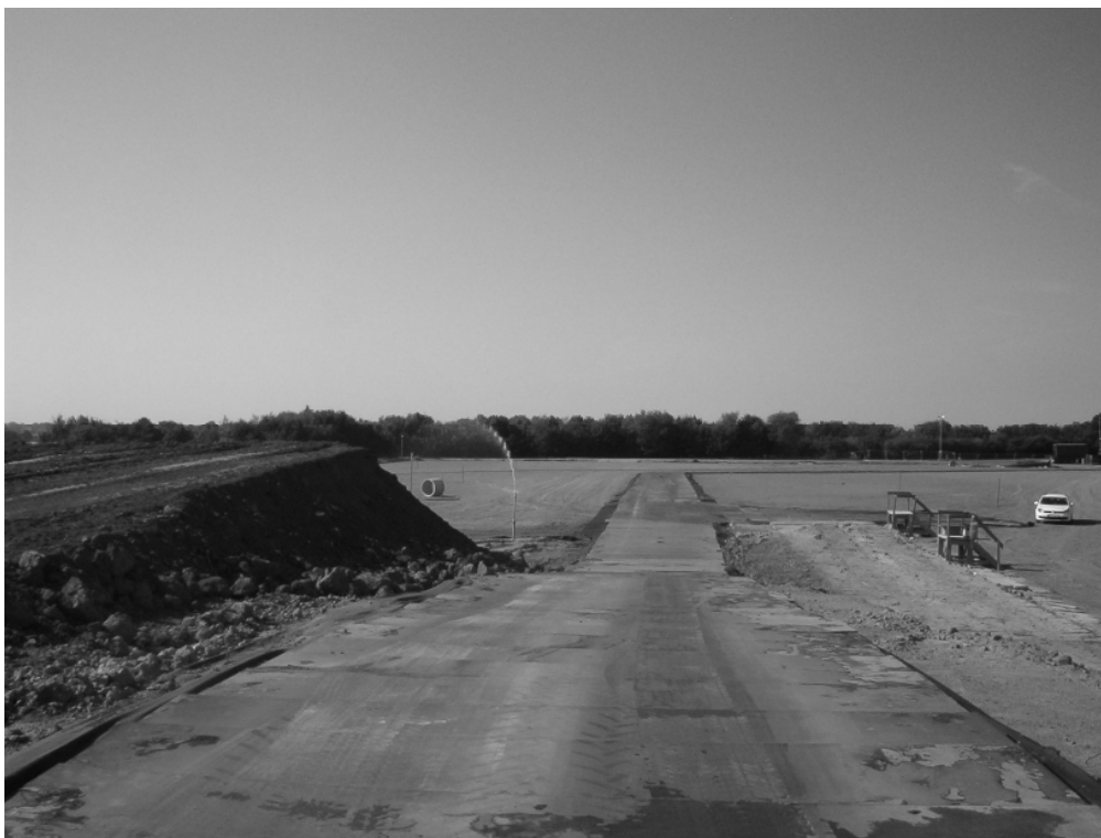
Abbildung 4: geosynthetisch bewehrte Baustraße im Baufeld
