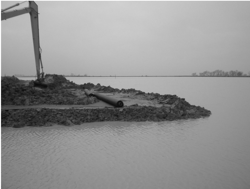
Abbildung 3; Einbau von Profilierungsmaterial mittels Langarmbagger
