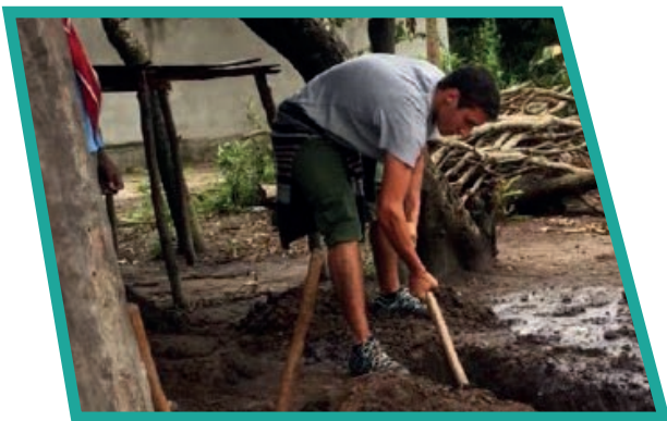
Construção do Telheiro-Cantina
