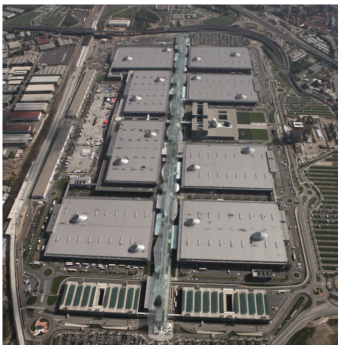
Le coperture dei padiglioni di fieramilano-Rho, sulle quali è in fase di realizzazione uno dei più grandi impianti fotovoltaici su tetto d'Europa
