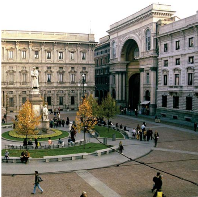
Palazzo Marino | Galleria Vittorio Emanuele II _ Edifici pubblici del centro storico che fruiscono del servizio di teleriscaldamento della rete urbana
