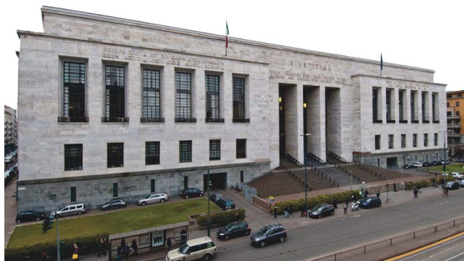
Tribunale di Milano _ Edificio pubblico del centro storico che fruisce del servizio di teleriscaldamento della rete urbana
