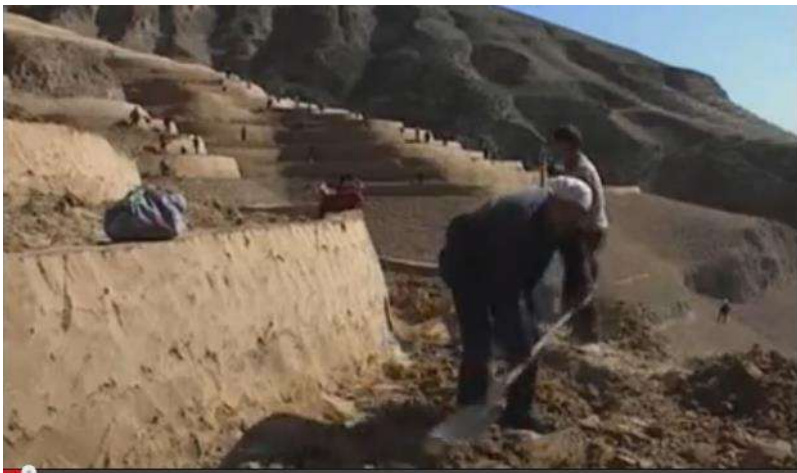
De aanleg van terrassen
