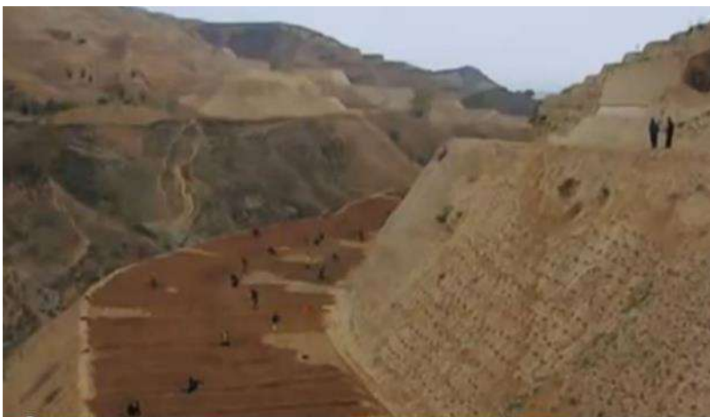
De terrasaanleg is klaar
