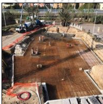
Foto_Nelle immagini getto per platea in Rck40 eseguito a Cagliari per la realizzazione di fondazione impermeabilizzata, getto in continuo di mc 350
