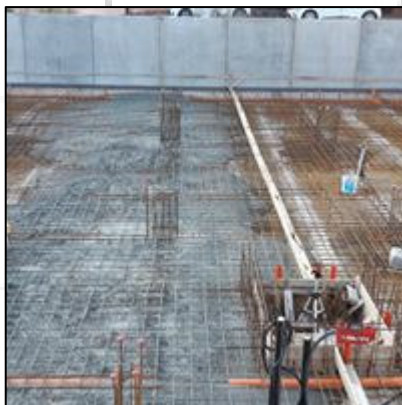
Foto_Nelle immagini getto di platea in Rck 40 eseguito a Cagliari per la realizzazione di fondazione impermeabilizzata, getto in continuo di mc 680
