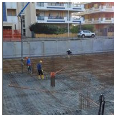
Foto_Nelle immagini getto di platea in Rck 40 eseguito a Cagliari per la realizzazione di fondazione impermeabilizzata, getto in continuo di mc 680
