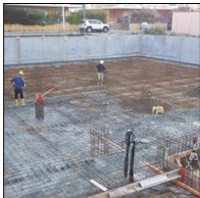
Foto_Nelle immagini getto di platea in Rck 40 eseguito a Cagliari per la realizzazione di fondazione impermeabilizzata, getto in continuo di mc 680
