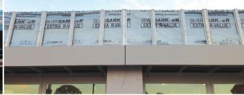
HIGH WATER BARRIER - MEDIUM VAPOUR BARRIER
