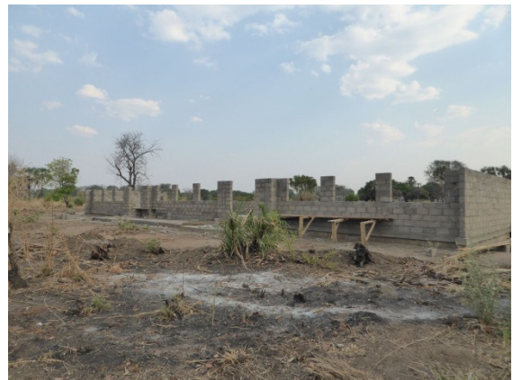
Bouw van drie nieuwe klaslokalen voor Chilubezi Community School (eind oktober 2016)
