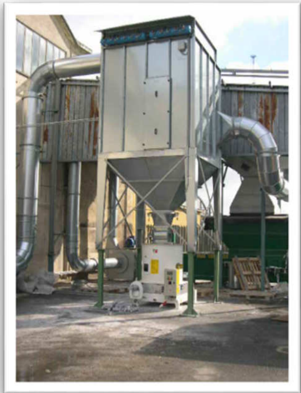
Filtro a maniche con bricchettatrice per grandi quantità di polvere.
