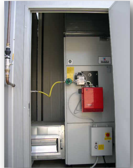
Box con generatore di calore alimentato con bruciatore a gas (vista esterna e interna).
