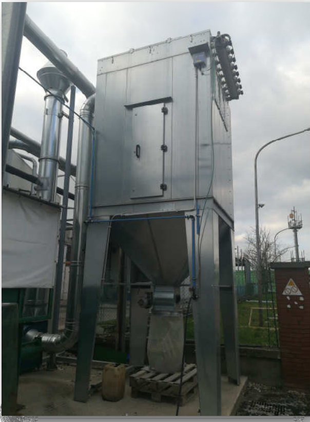
Filtro a cartucce per aspirazione rifili carta con fotocellula e sacco raccolta polvere.
