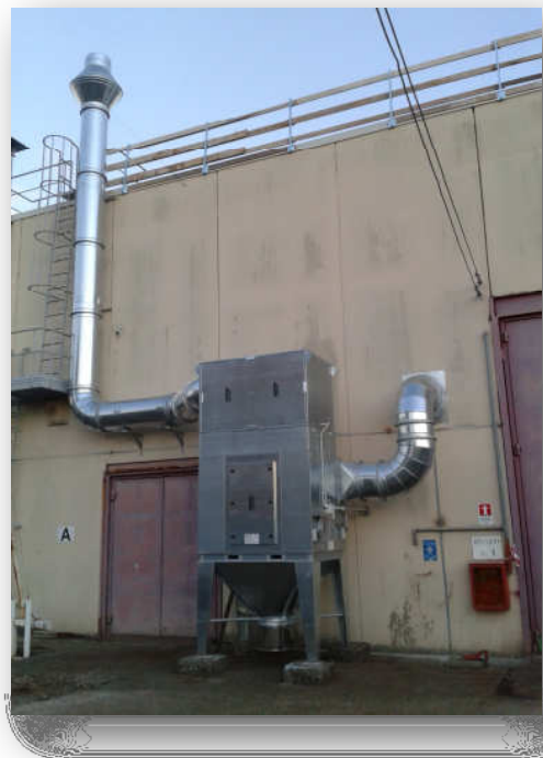
Filtro a cartucce con ventilatore silenziato incorporato.
