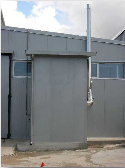
Box con generatore di calore alimentato con bruciatore a gas (vista esterna e interna).
