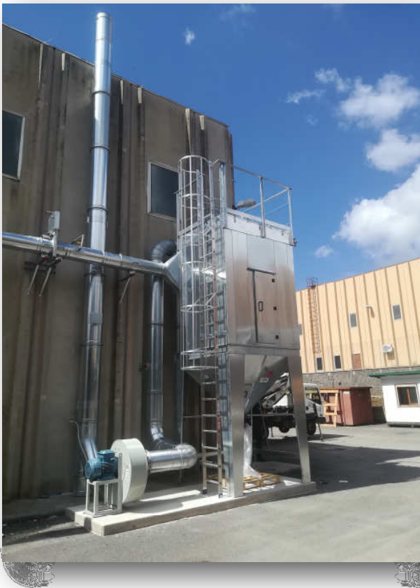
Filtro abbattimento polveri autopulenti a cartucce con ventilatore e serranda tagliafuoco.
