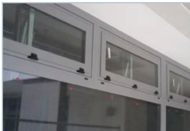
Aperture laterali per l'afflusso di aria fresca.
