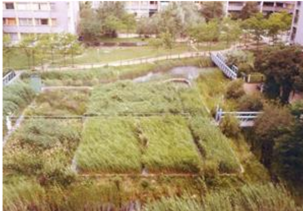
Sistema di fitodepurazione a flusso sommerso per il trattamento di acque grigie
