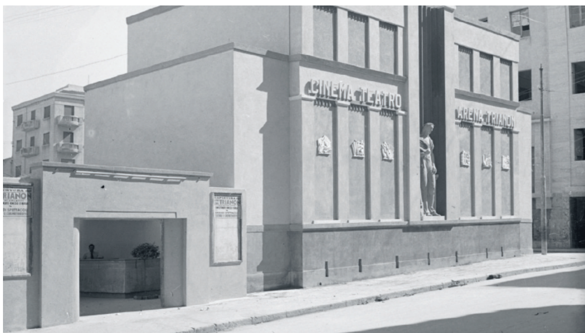
Recupero della memoria. La facciata dell'arena Trianon progettata dall'ingegnere Giovanni Pernice
