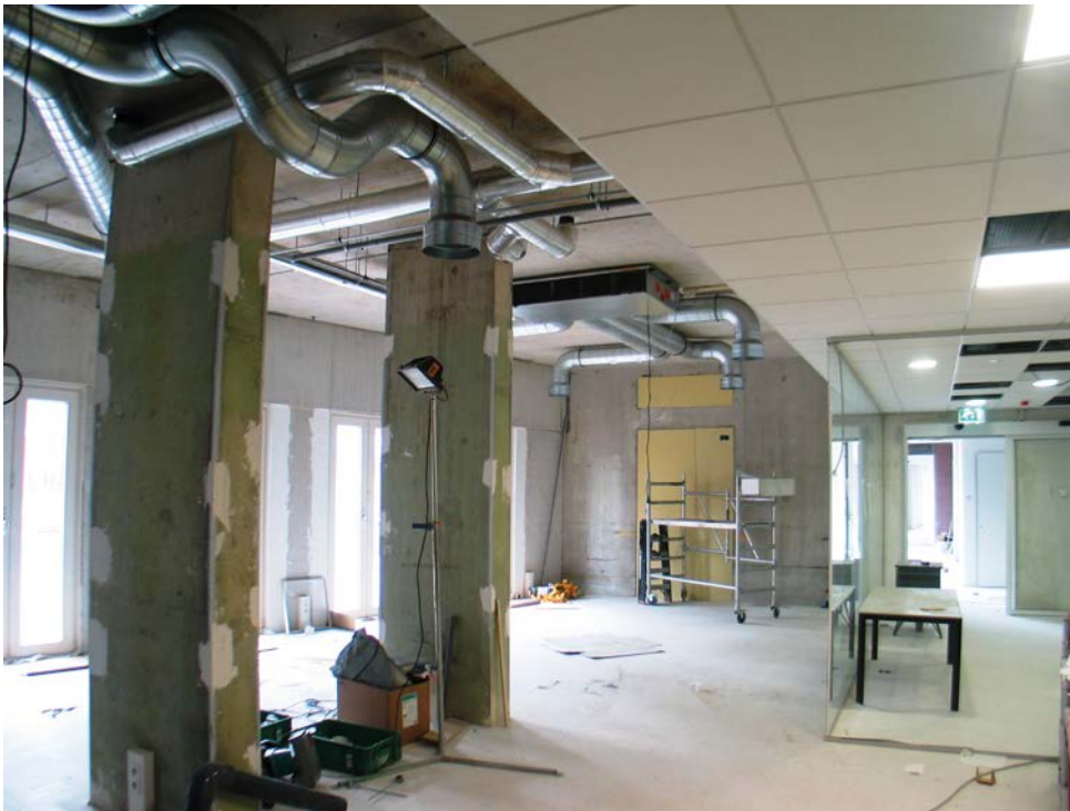
De klimaatinstallatie in opbouw.
