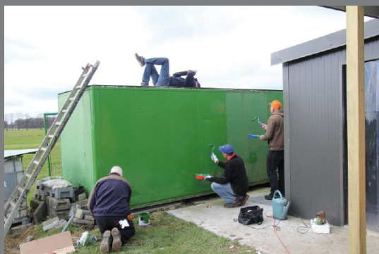
Een proper geschilderde stroomgenerator en container
