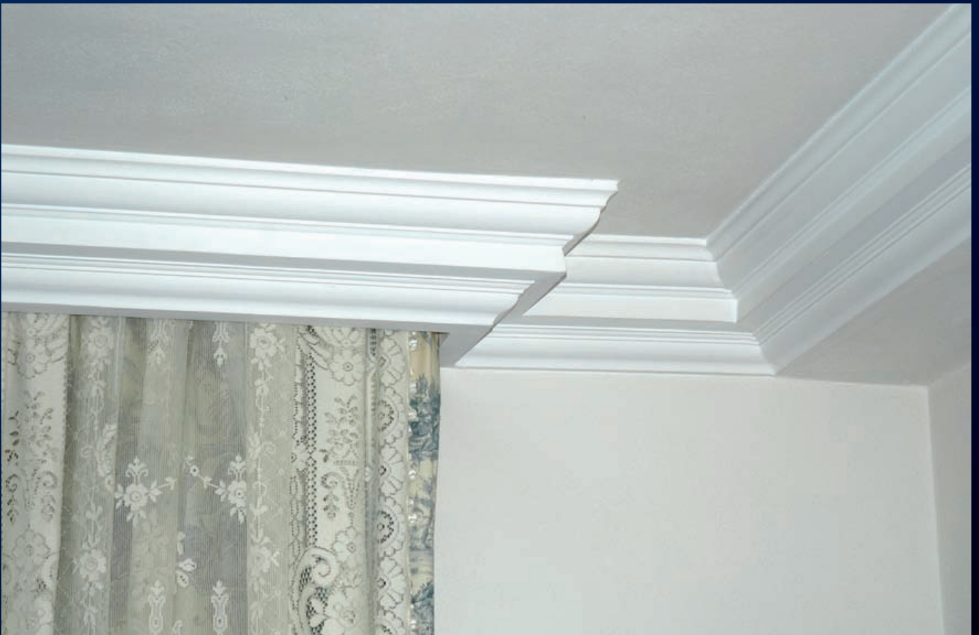
Abitazione Privata - Colle di Val D'Elsa (SI) Private home
