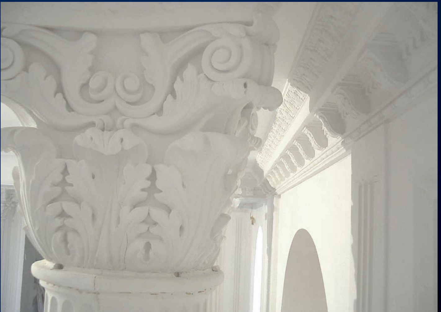
Villa privata - Yerevan (Armenia) - Private villa - Yerevan (Armenia)
