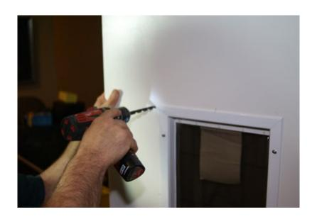
4) INSTALL THE TAMPER RESISTANT SCREWS OR BOLTS. (DO NOT TIGHTEN YET, YOU MUST ALIGN AND DRILL THE REMAINING THREE HOLES).
