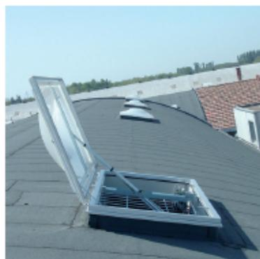
Apertura elettrica costituita da telaio e controtelaio in alluminio estruso naturale lega UNI6060 assemblato per cinfrinatura, completo di guarnizione di tenuta, cerniere in alluminio, rivetti e viterie in acciaio inox. Il dispositivo di apertura composto da motore elettrico 220V. Pu essere fornito con motore a stelo 220V corsa mm 300 oppure con motore a cremagliera singolo o tandem 220V corsa mm350. Staffe di supporto e regolazione in acciaio zincato.
