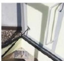
Coperchio in lamiera zincata pressopiegata sp. 15/10 con trattamento di verniciatura a fuoco in epossipoliestere colore grigio RAL 9007. Coibentazione in poliester sp. 20 mm. Ammortizzatori, guarnizioni in battuta perimetrale, chiusura a catenaccio e cerniere in acciaio.
