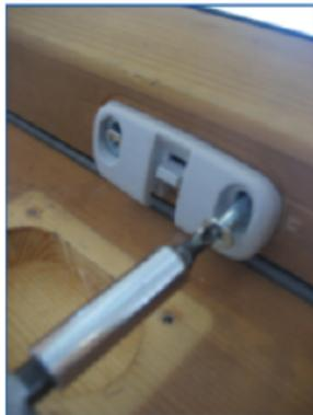
4) Avvitare il riscontro (staffa di fissaggio al battente) con le proprie viti a dx e a sx.
