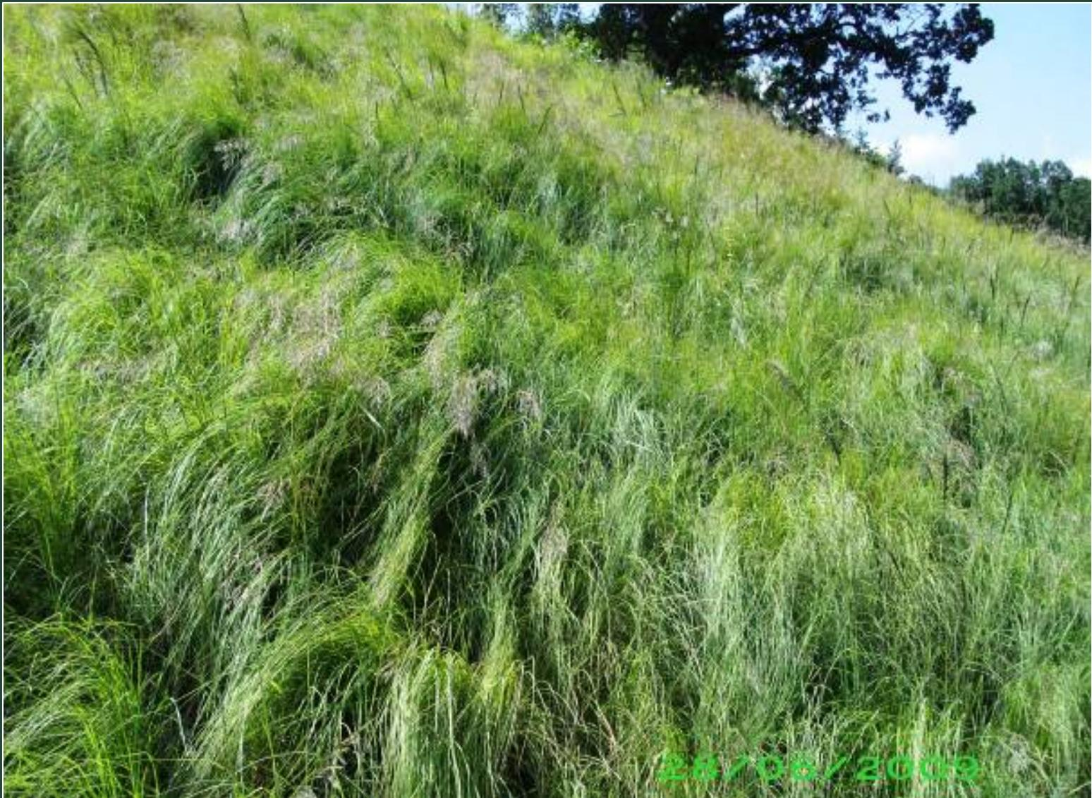
*La copertura vegetale di una scarpata sull'Autostrada A3 con i PRATI ARMATI®*
