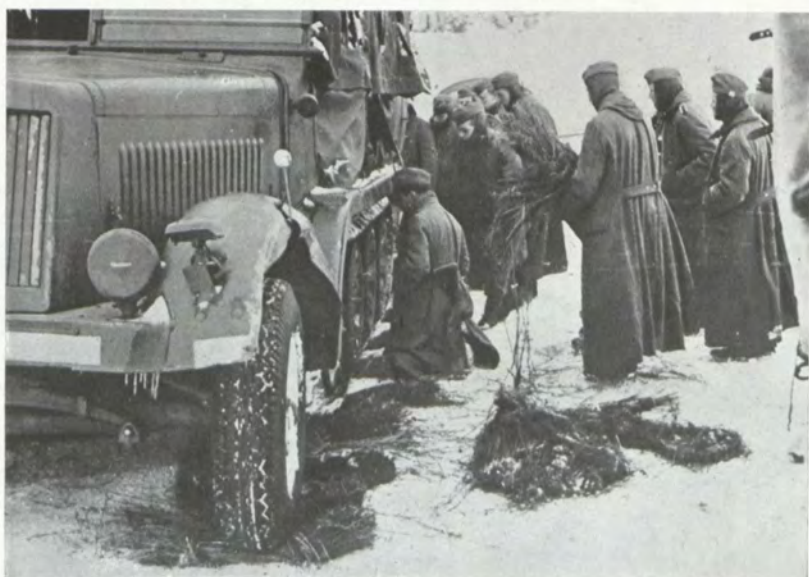
Soldados procurando desencravar um carro pesado, colocando palha e junco sob as rodas e chenilles para evitar que patine sobre o gelo
