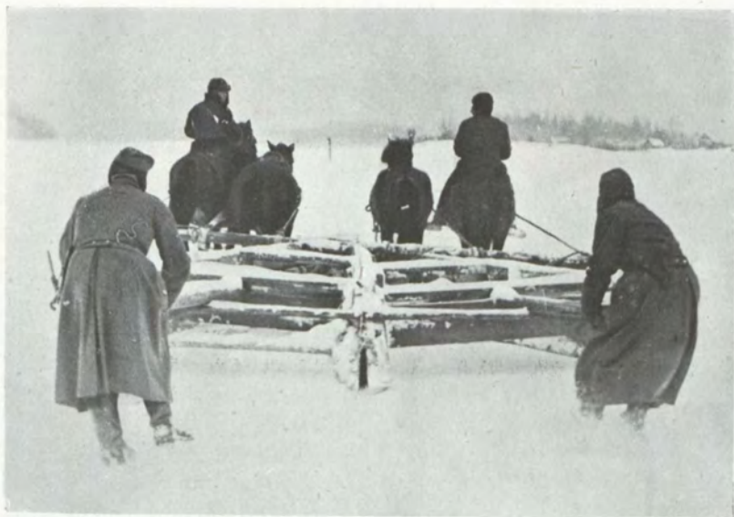
Soldados alemães desobstruindo uma estrada por meio de um limpa-neve improvisado, construído em madeira e puxado por cavalos
