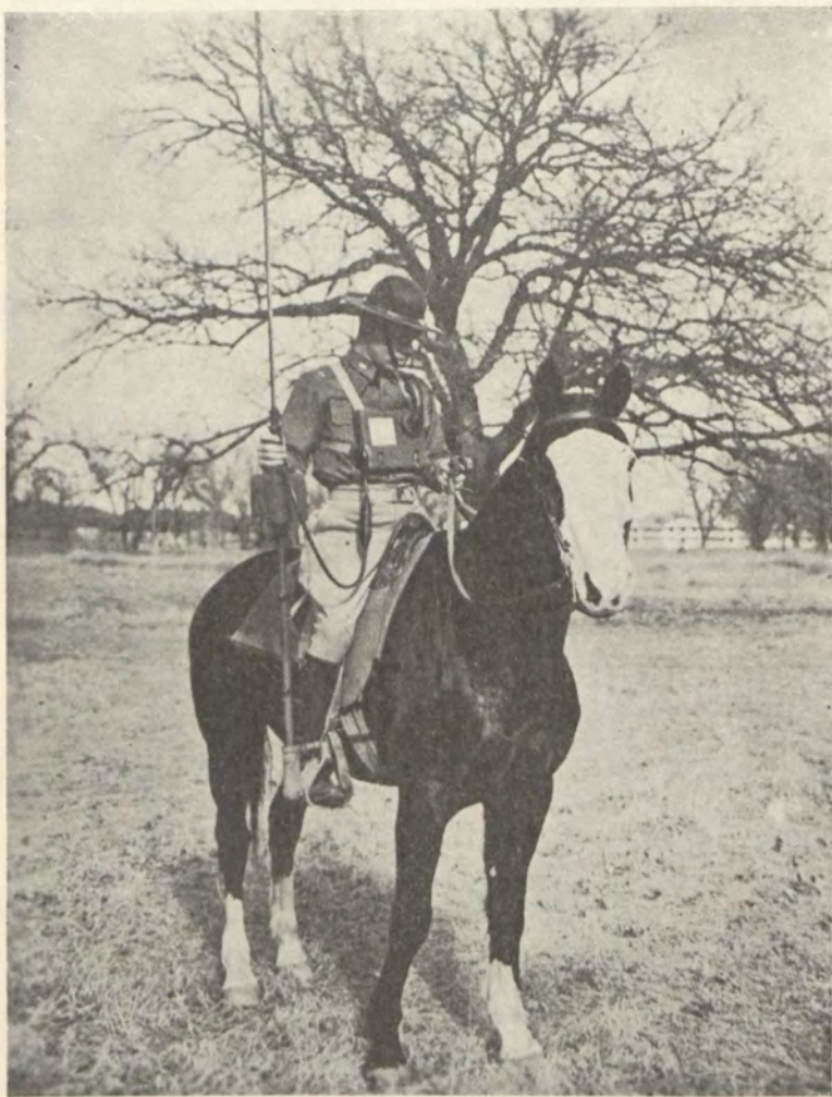
Um tenente de Cavalaria dos Estados Unidos demonstra o novo aparelho rádio emissor usado pela Cavalaria — É utilizado a cavalo durante a marcha — O aparelho tem um raio de transmissão de 26 milhas.
