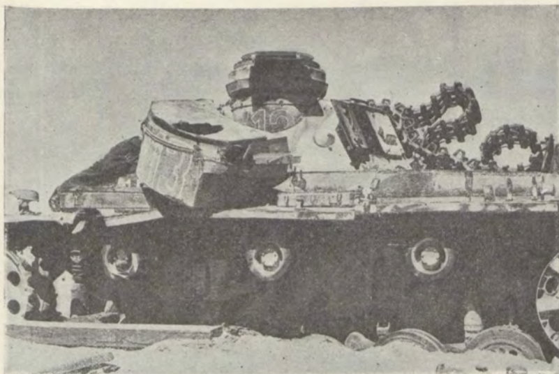
Carro de combate Mark III, com a torre deslocada pelo fogo de uma granada
