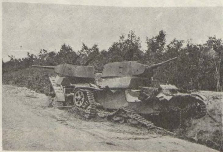
Frente de Leninegrado: Carros de combate russos avariados no campo da luta. — A chenille continua sendo a parte vulnerável dos carros. Todos os carros inutilizados que observámos, tinham sido primeiramente imobilizados pela destruição das chenilles.
