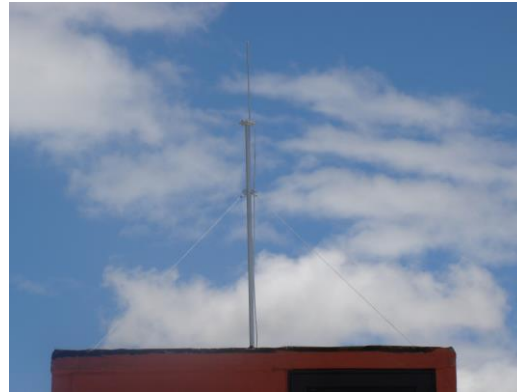
SISTEMA DE PROTECCION EXTERNA CONTRA DESCARGAS ATMOSFERICAS AMERICAS CLUB RESIDENCIAL
