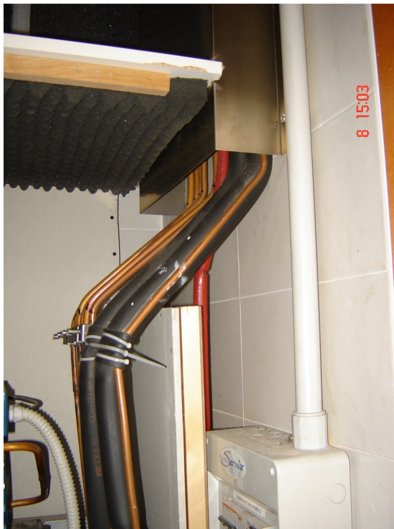
Figura 2 – Canalizzazioni delle macchine frigorifere, desolidarizzate dalla struttura dell'edificio
