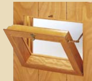
2. Sopraluce inserito nell'anta mobile con apertura a wasistas, con due o quattro finestrelle (a vetri oppure in lamiera forata).
