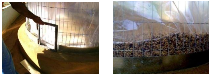
Figura 166 - Silo secador-armazenador: (a) colocação da porta para descarga; e (b) enchimento.
