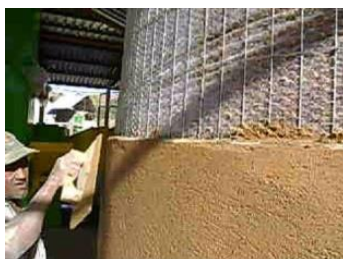
Figura 167 - Revestimento externo do silo com argamassa e detalhes da armação metálica.
