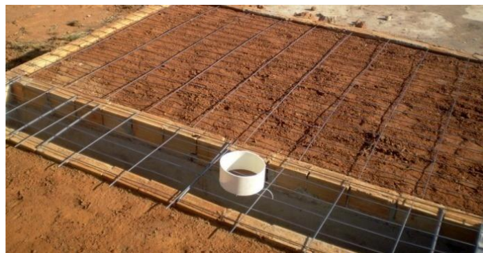
Figura 72 - Detalhe da construção da laje piso e colocação dos anéis de PVC para formar a tomada de ar quente.
