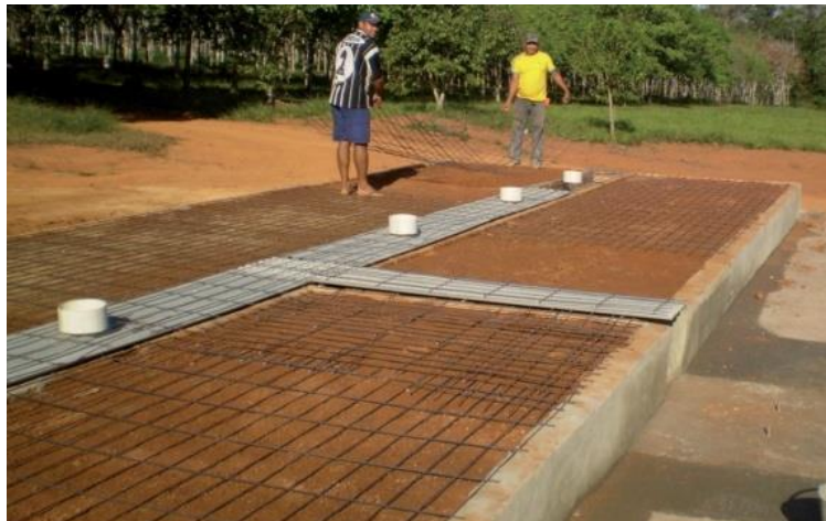
Figura 74 - Detalhes dos anéis de PVC para formação das tomadas de ar quente, antes de adicionar o concreto para formação do piso.
