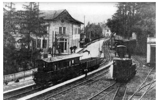
**La ferrovia Menaggio – Porlezza** è stata inaugurata nel 1884 e dismessa nel 1939, lunga 12,2 Km partiva da Menaggio di fronte all’imbarcadero (edificio rosa ancora visibile oggi). Per superare il dislivello di 170 m fra Menaggio (207 m) e Cardano (377 m) la linea ferrata dapprima si dirigeva per circa 900 m verso Como, con una pendenza del 5%, poi ritornava indietro grazie alla manovra chiamata “**regresso**” che avveniva dov’era ubicato il casello numero 2 e poi proseguiva verso nord.
