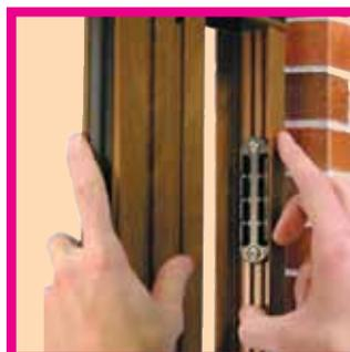
Dettaglio Compensatore laterale con clips applicate
