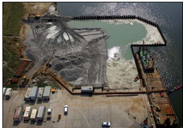
Erweiterung LP 60 (Bauzustand 2006)
