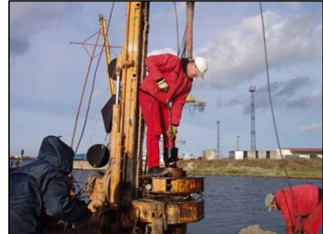
Einbau der wasserseitigen Messgeber mittels Wasserbohrungen
