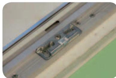
Soglia per porta balcone in alluminio alta 24 mm
