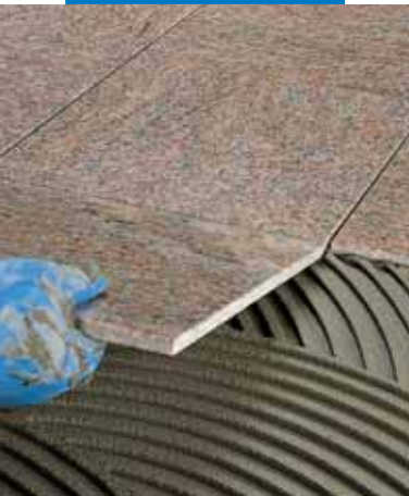
Posa di marmo prelevigato a pavimento
