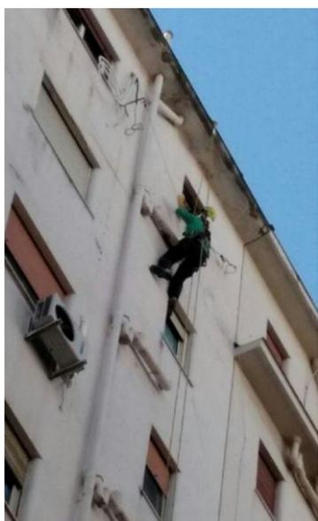
Sostituzione tratto di colonna di scarico in Via Laurana 73, (PA).
